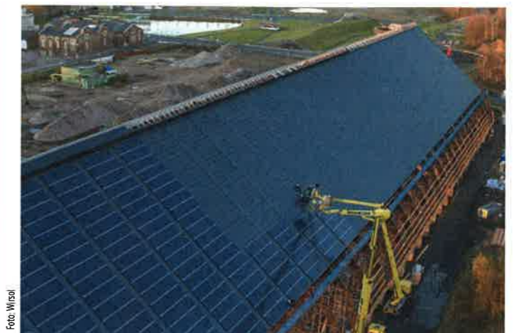
Für die Installation mussten riesige Hubsteiger her, die bis zum Dachfirst reichten.
