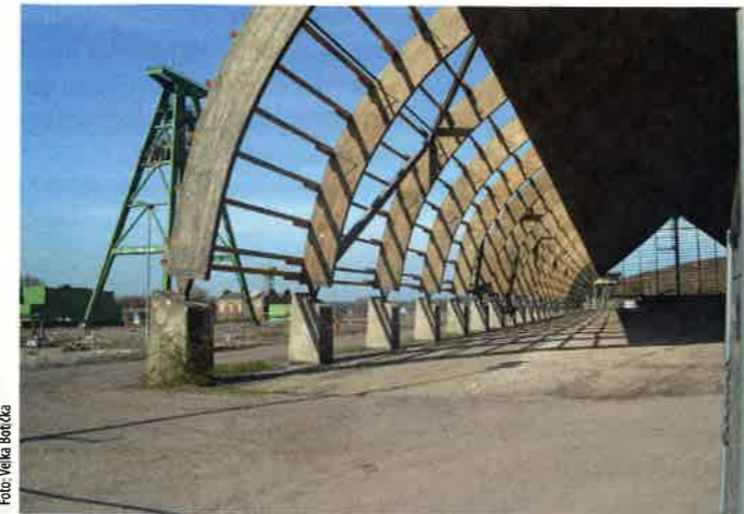
Die dicken Leimbinder auf beiden Seiten der Halle mussten alle saniert werden.
