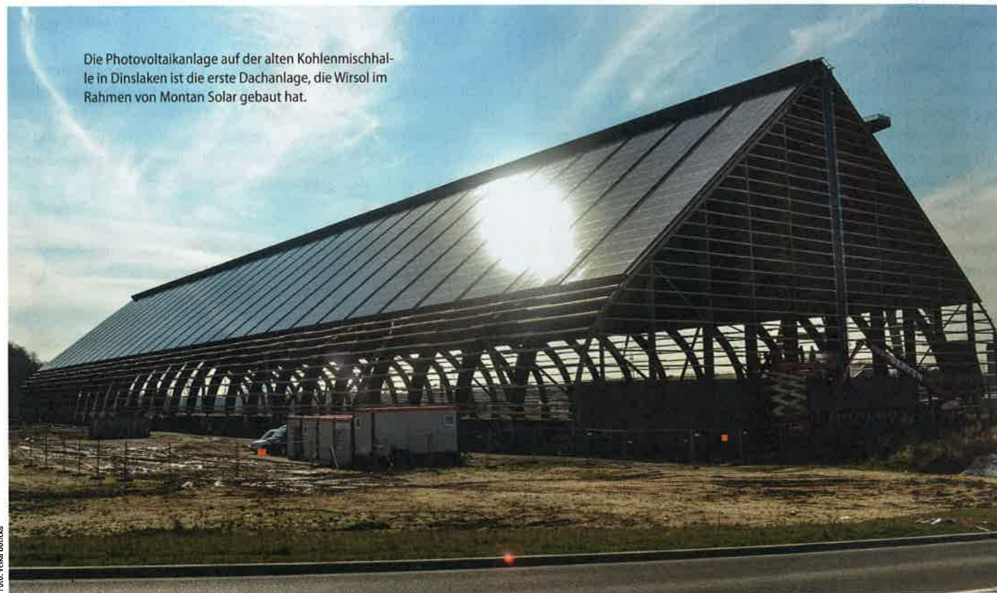
Die dicken Leimbinder auf beiden Seiten der Halle mussten alle saniert werden.
