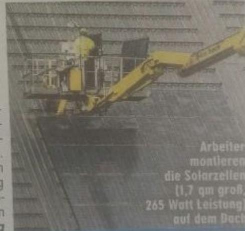
Arbeiter montieren die Solarzellen (1,7 qm groß, 265 Watt Leistung) auf dem Dach
