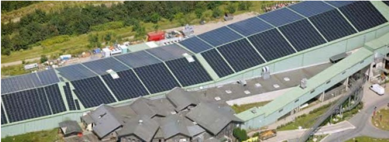
Ein Blick auf das Dach der Skihalle Foto: Hans Blosssey
